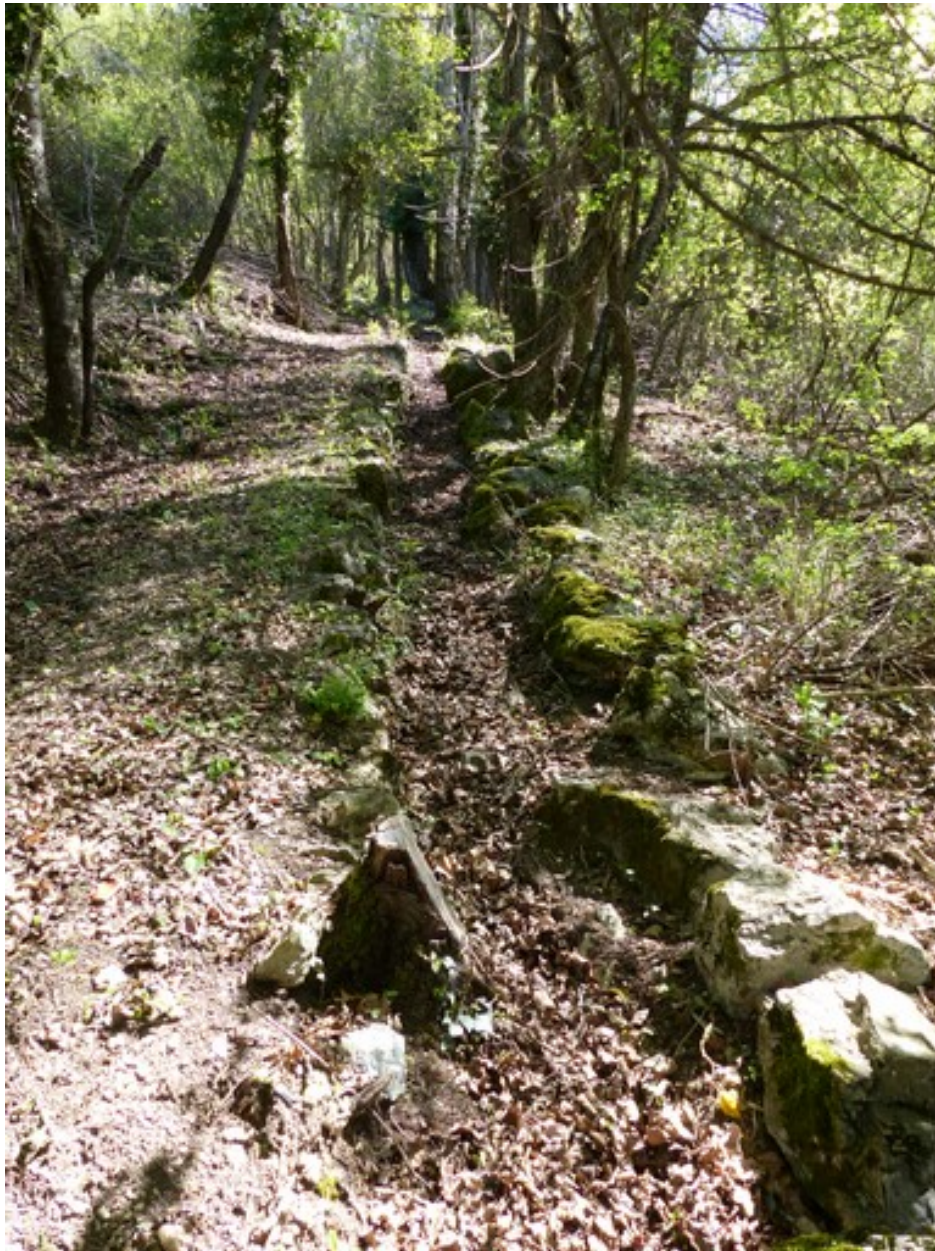
Canal de pente, au quartier de La Combe.
