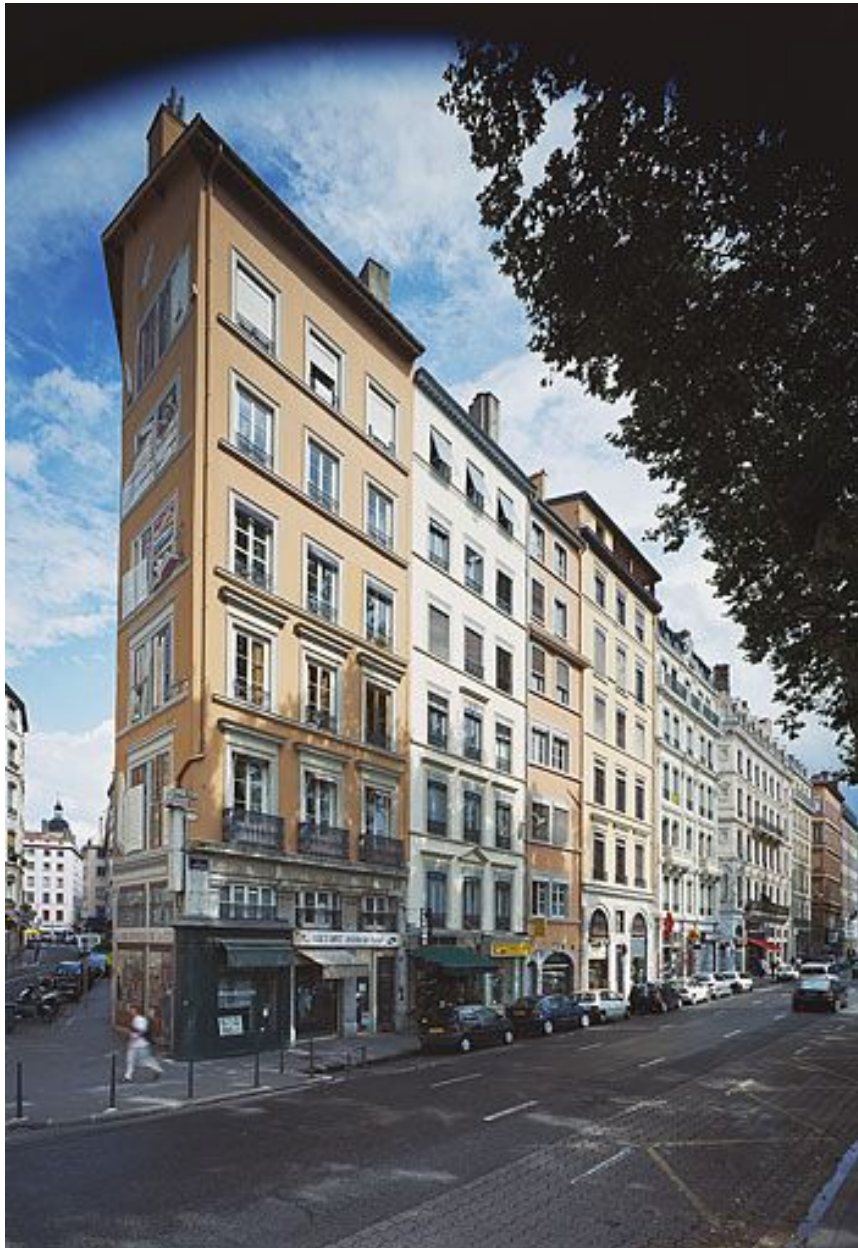
Vue générale des façades 6 à 9, quai Pêcherie
