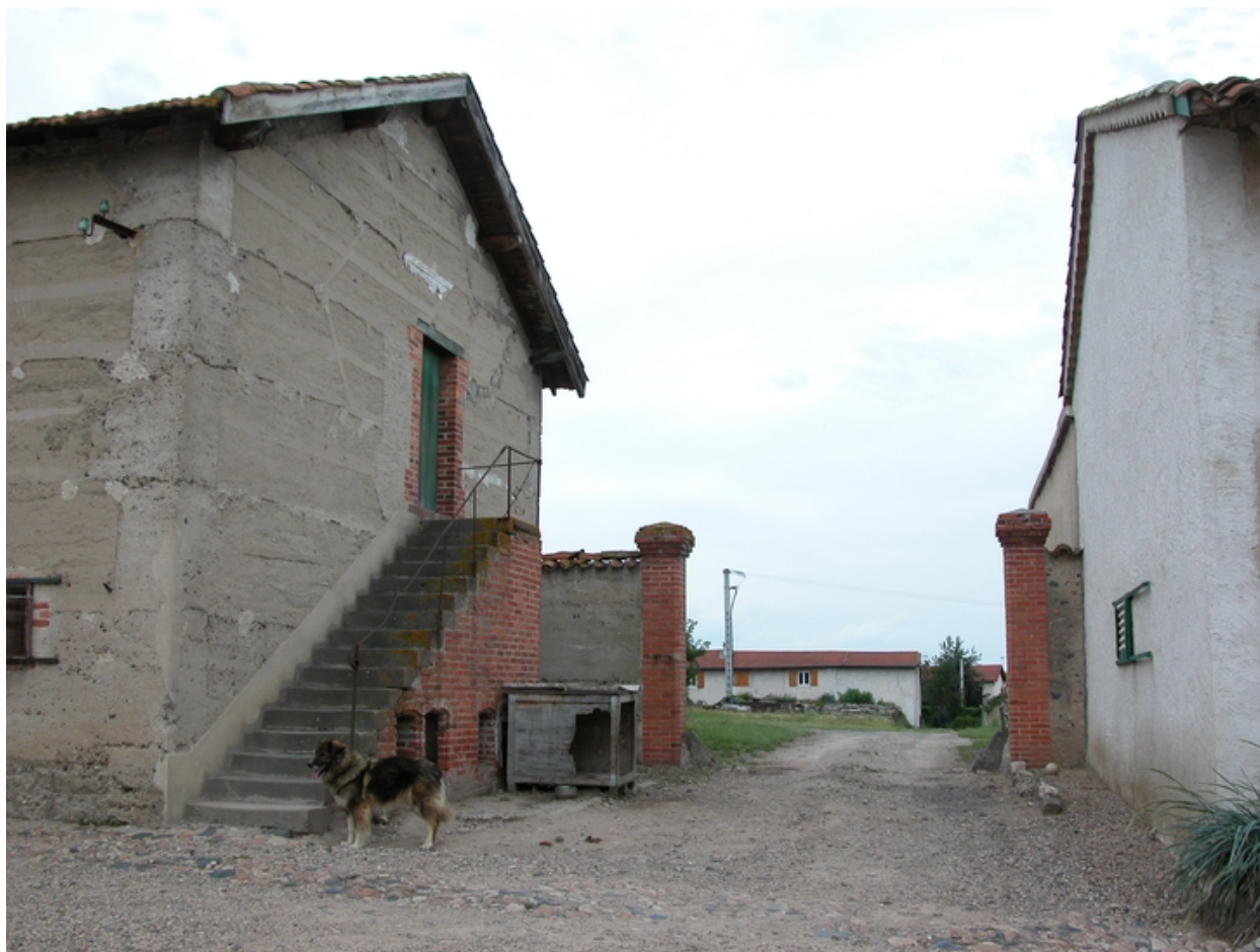
Mur pignon de la grange-étable nord-ouest : escalier extérieur, portail.
