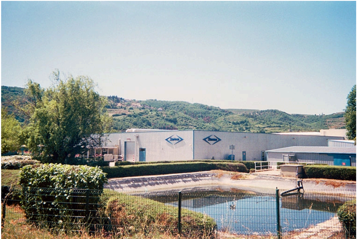
Façades sud et est
