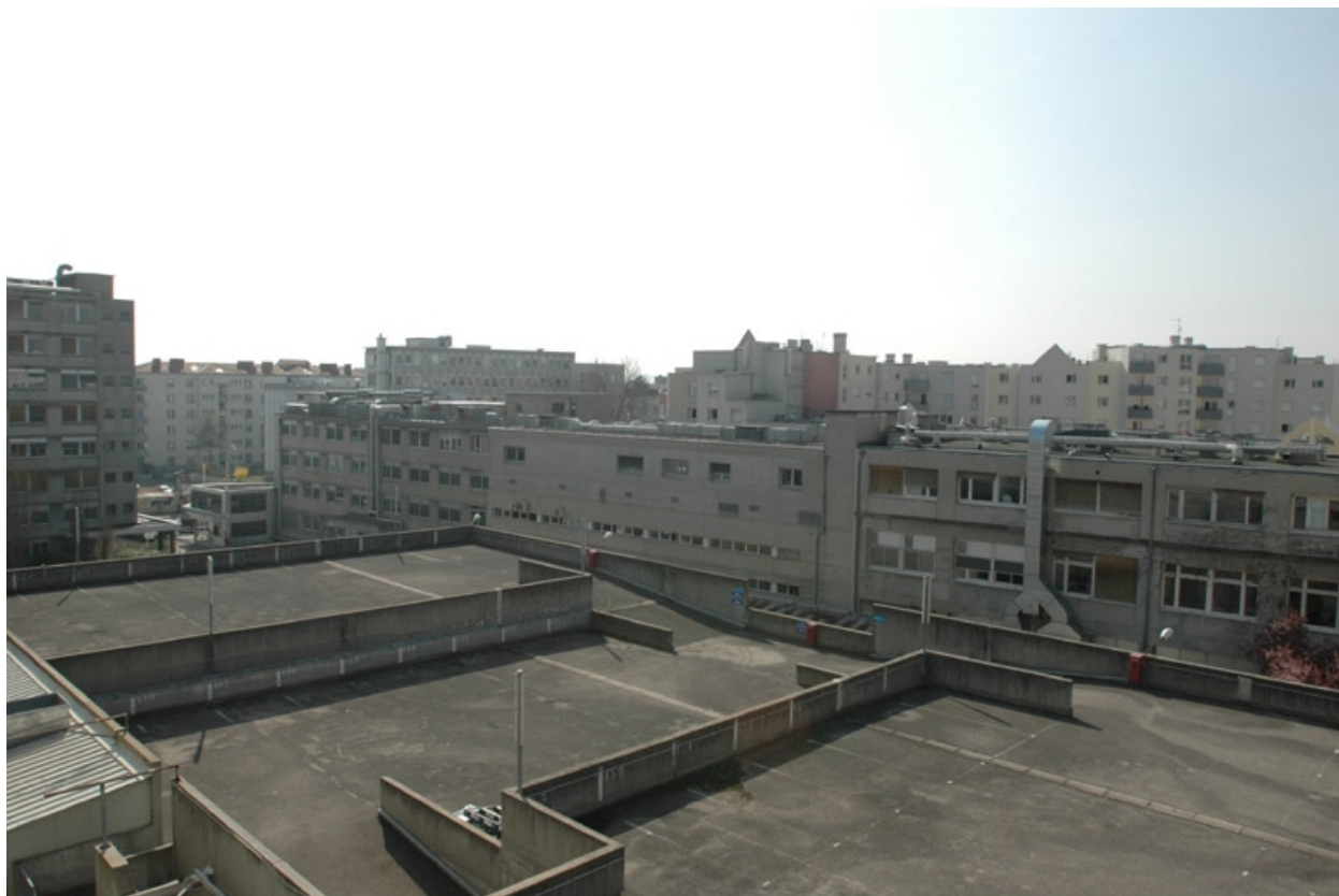
Vue nord-est des toitures
