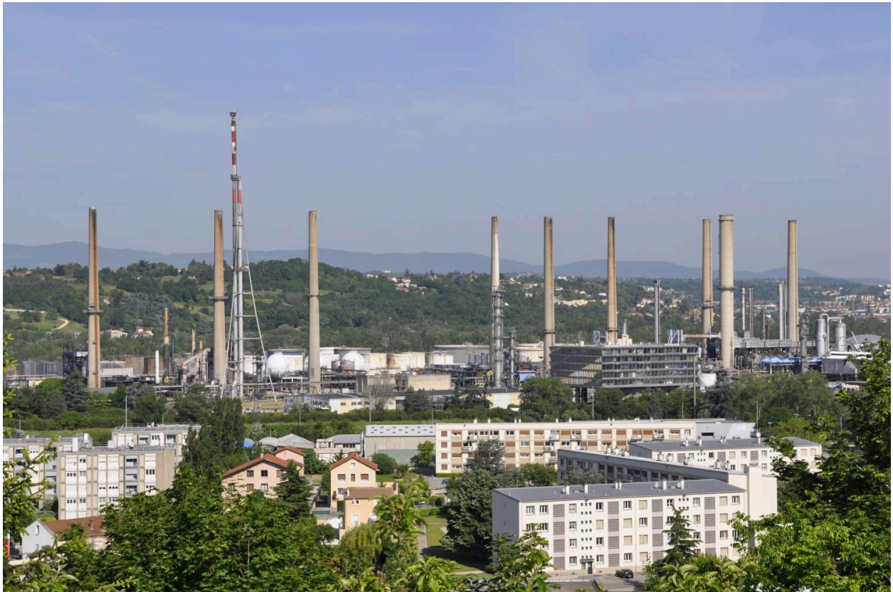
Vue des cheminées
