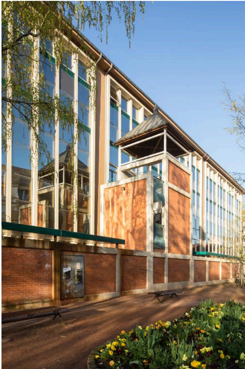
Bâtiment B. Façade rue Jean-Puy
