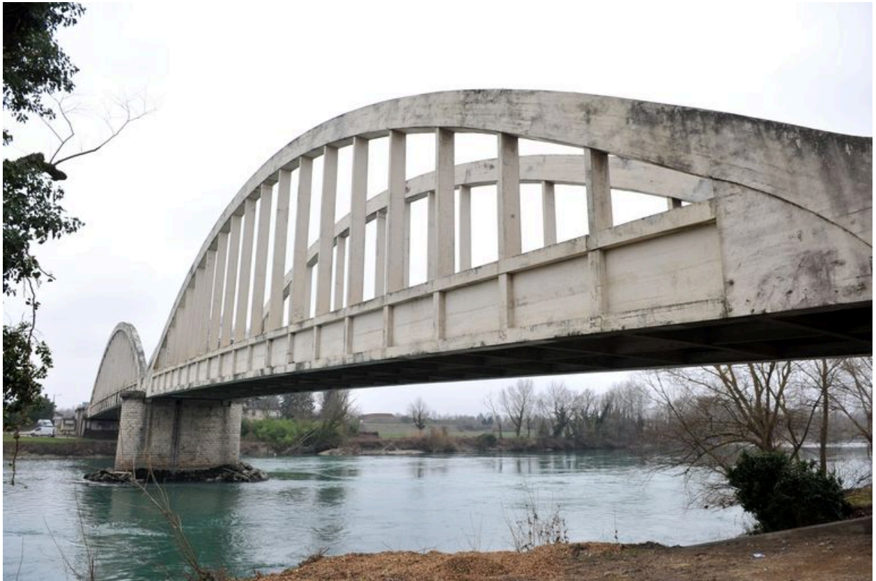
Vue générale, de côté, face amont (depuis la rive droite)
