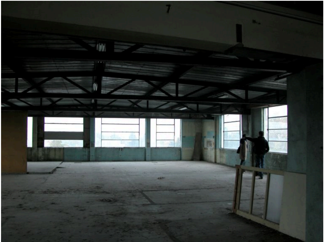
El  ment de charpente de l'aile nord de l'usine.
