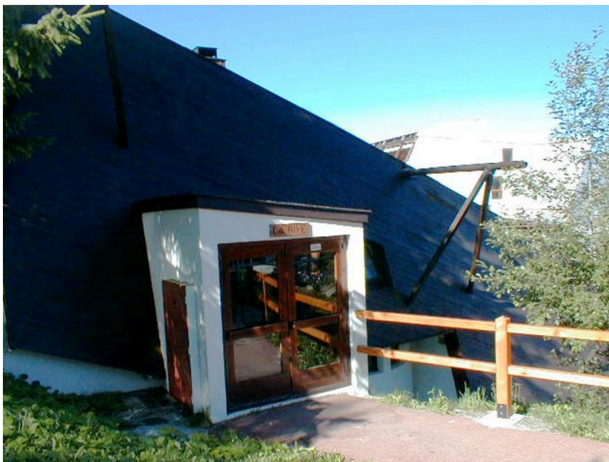
Façade nord : une entrée
