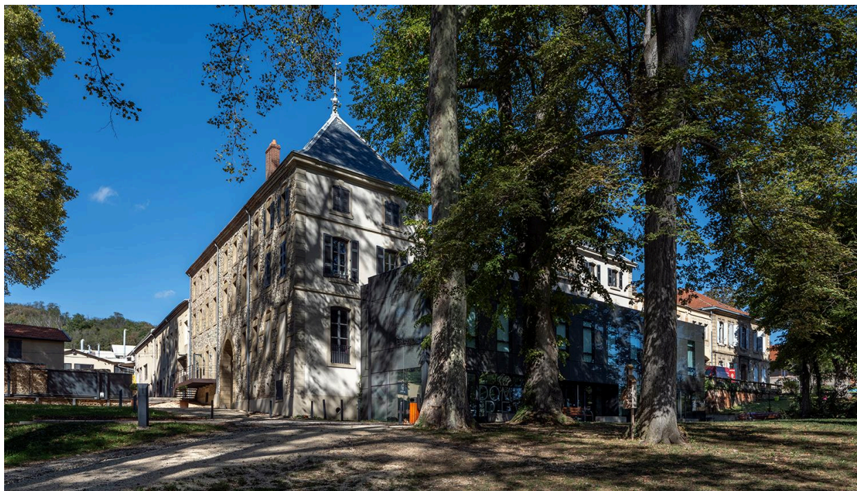
Usine de céramique culinaire "Revol porcelaine" vue extérieure
