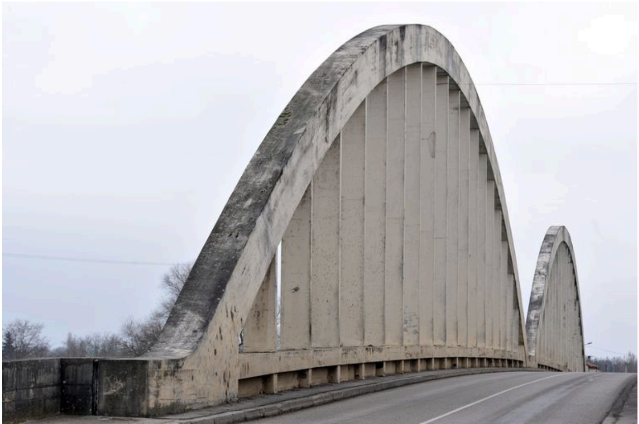
Vue partielle, de dessus, arches de la face amont (depuis la rive droite)
