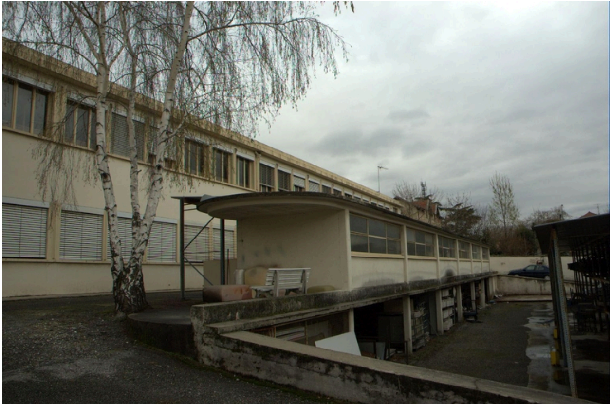
Locaux techniques, vues nord
