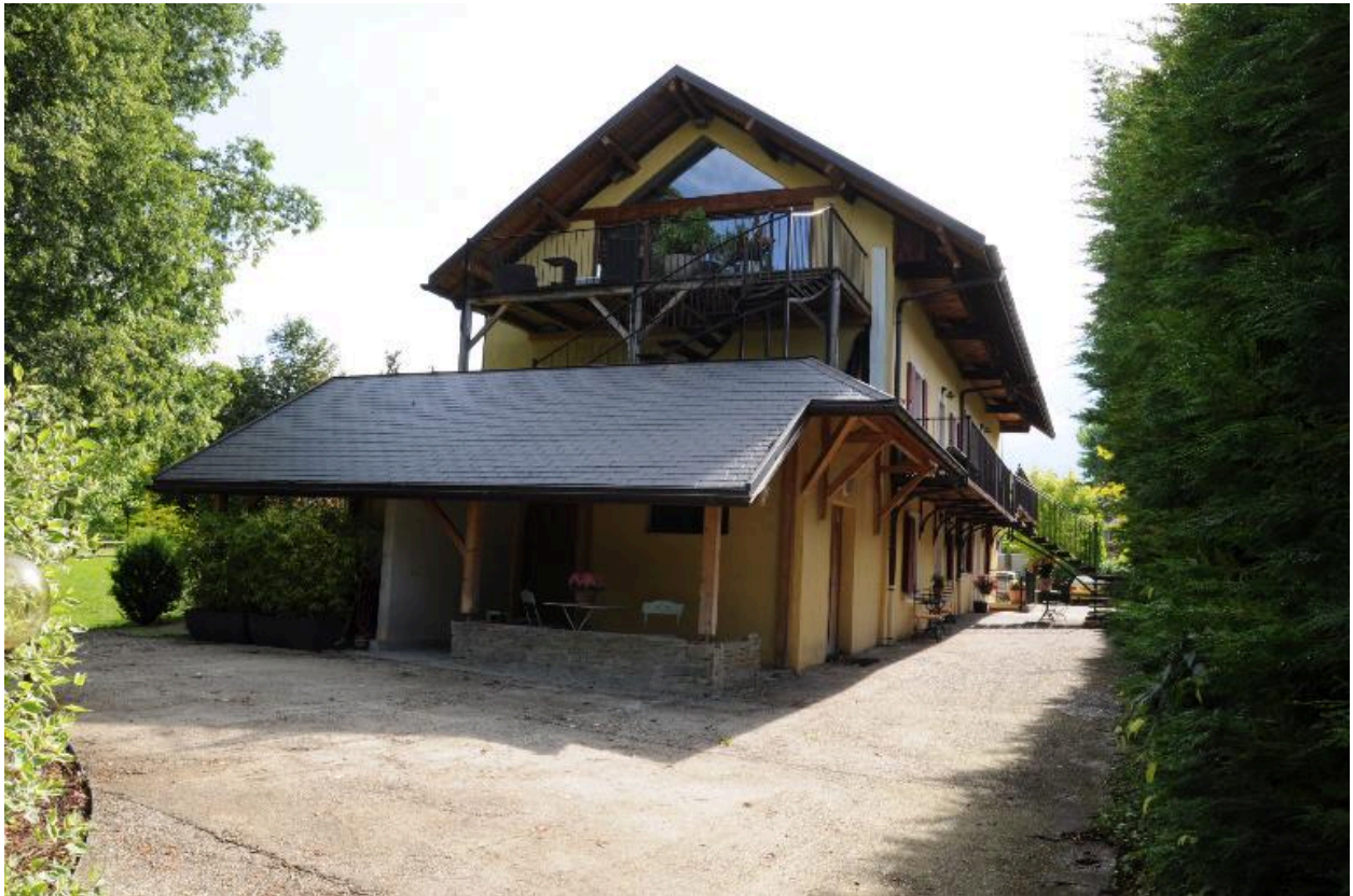
Pignon ouest et façade sud
