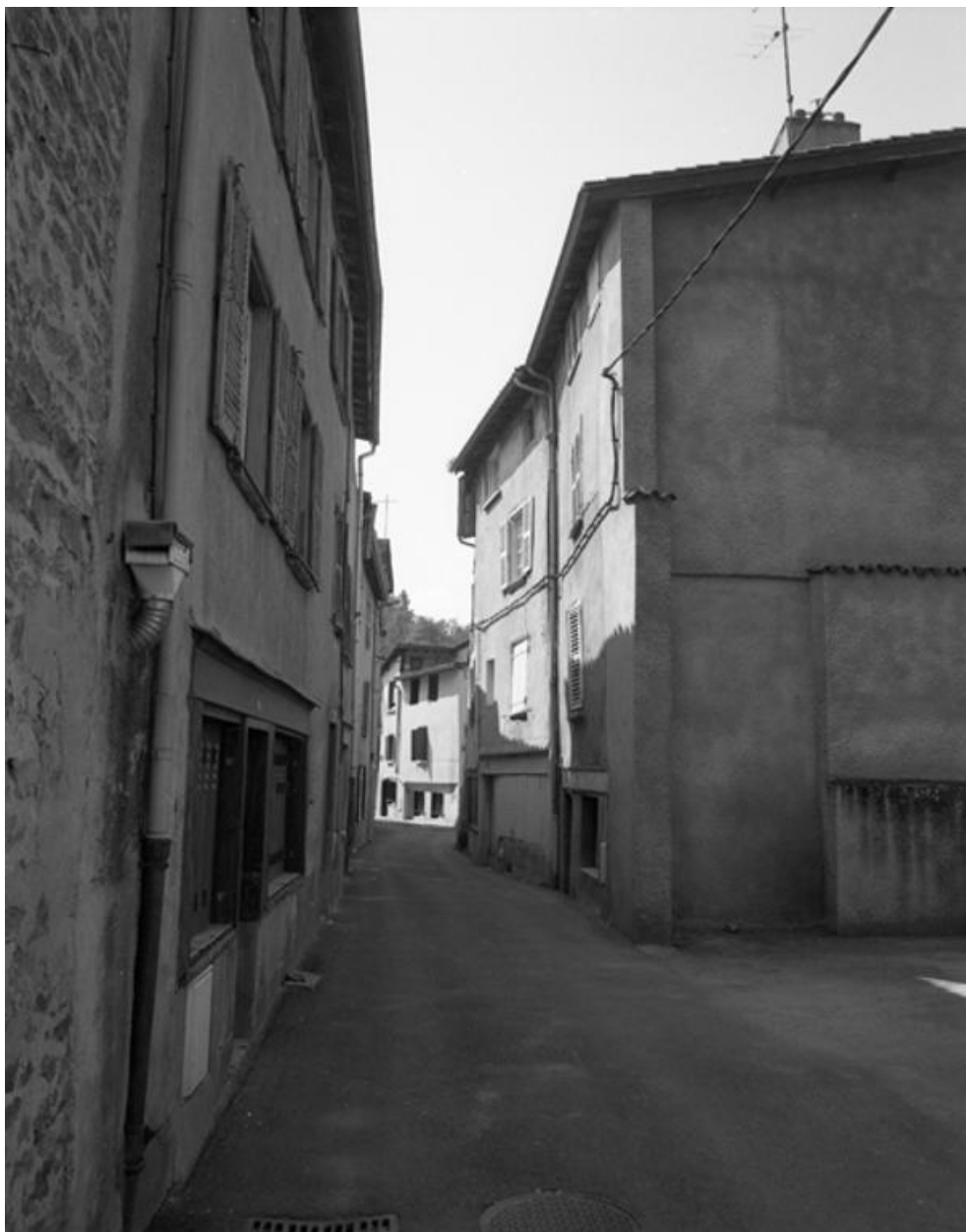
Partie basse de la rue, avant travaux.
