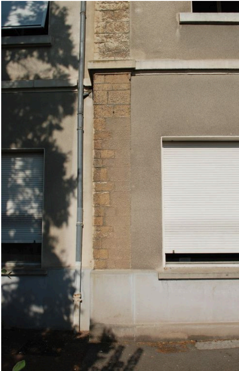
Détail du chaînage d'angle en moellons piqués, façade est
