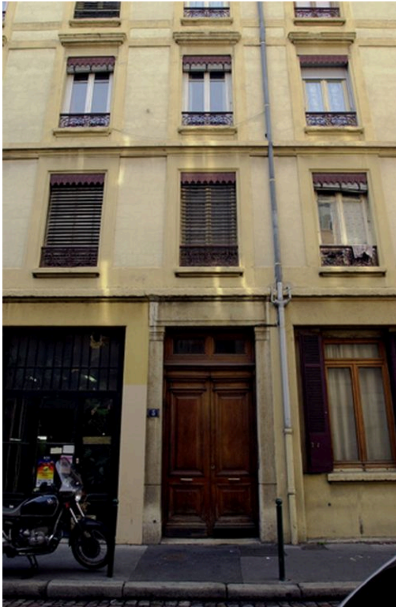
Vue d'ensemble de la travée centrale
