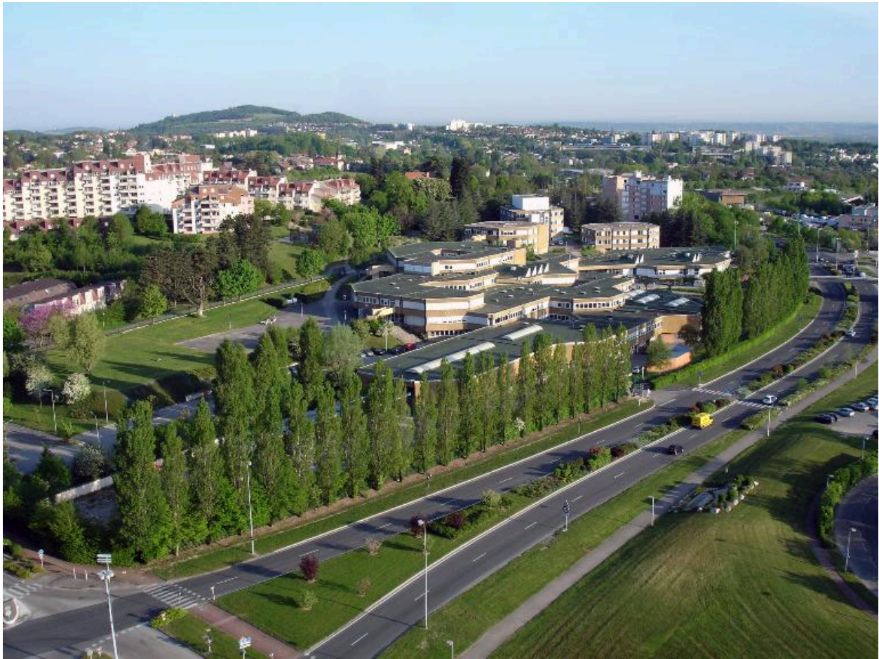
Lycée Léonard de Vinci, Villefontaine, 1976-1981 (Isère) : vue aérienne (coll. D. Gomard)
