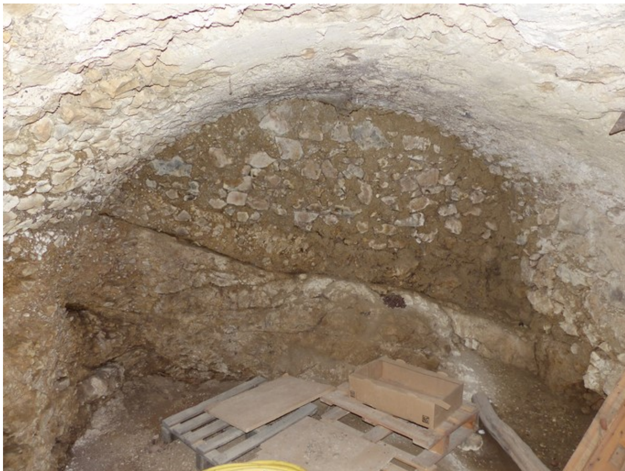
Second étage de soubassement, étable. Mur est, maçonnerie assise sur le rocher.
