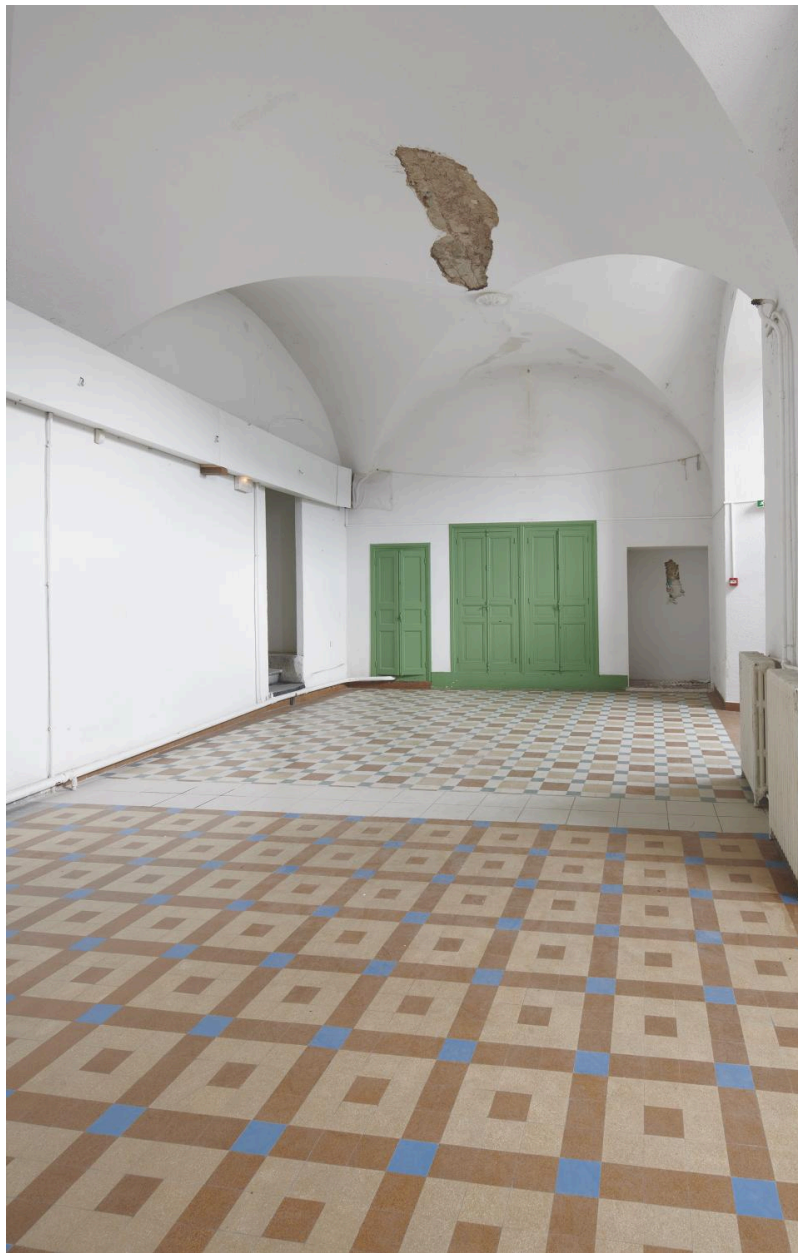
Aile est, rez-de-chaussée : salle de réception, depuis le sud
