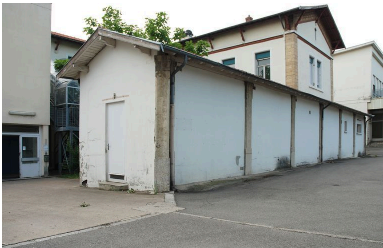
Façade principale (ouest), vue depuis le nord-ouest : galerie transformée en bâtiment, piliers en pierre de taille
