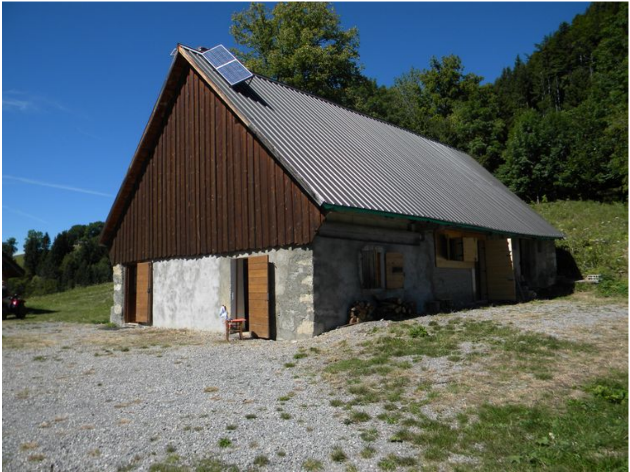
Vue générale de la ferme remaniée du Chénay
