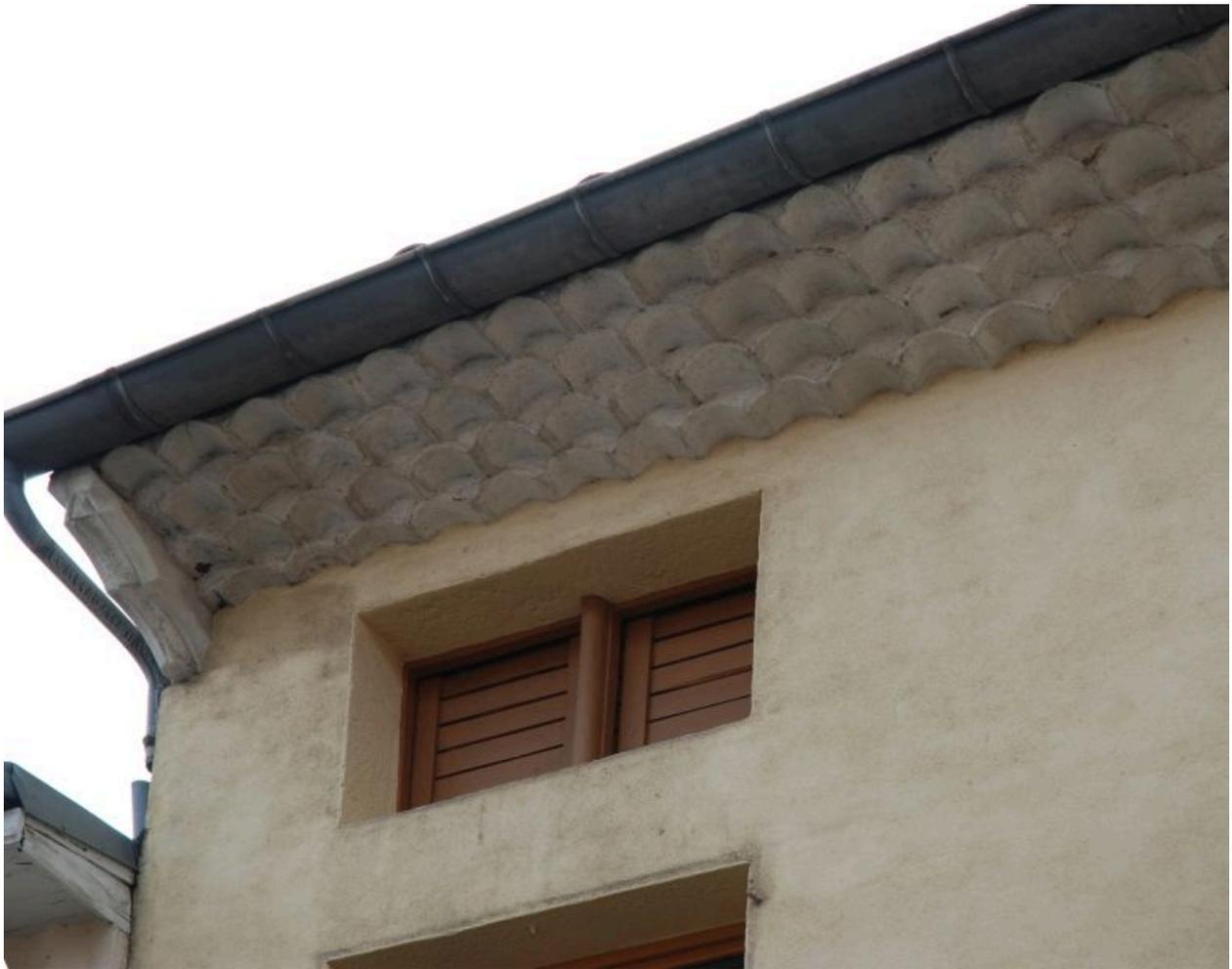
Détail de l'étage en surcroît : baie avec meneau de bois, avant-toit soutenu par des consoles et fermé par une génoise.
