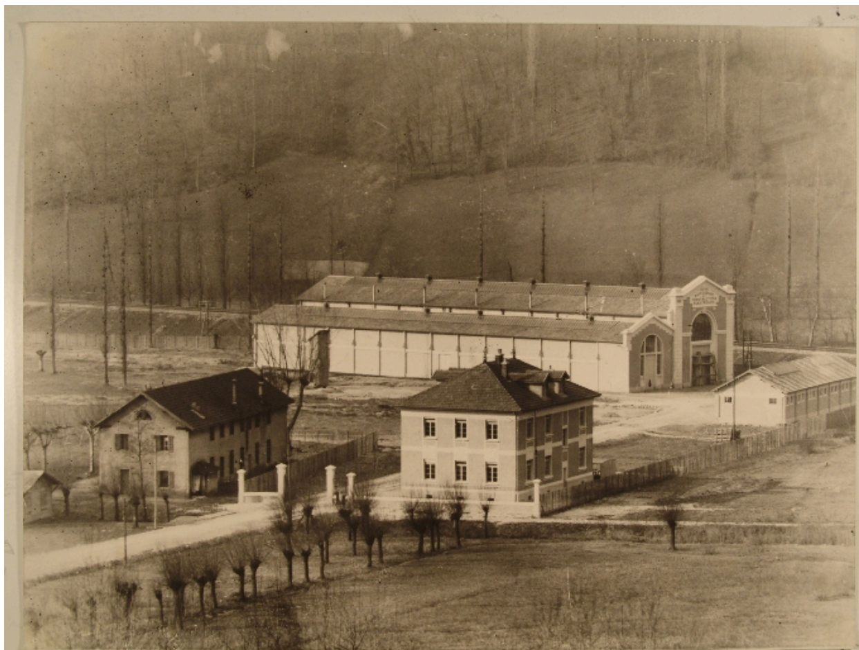
Vue générale de l'usine en 1921
