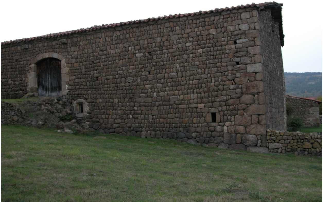
Vue arrière de la grange-étable.
