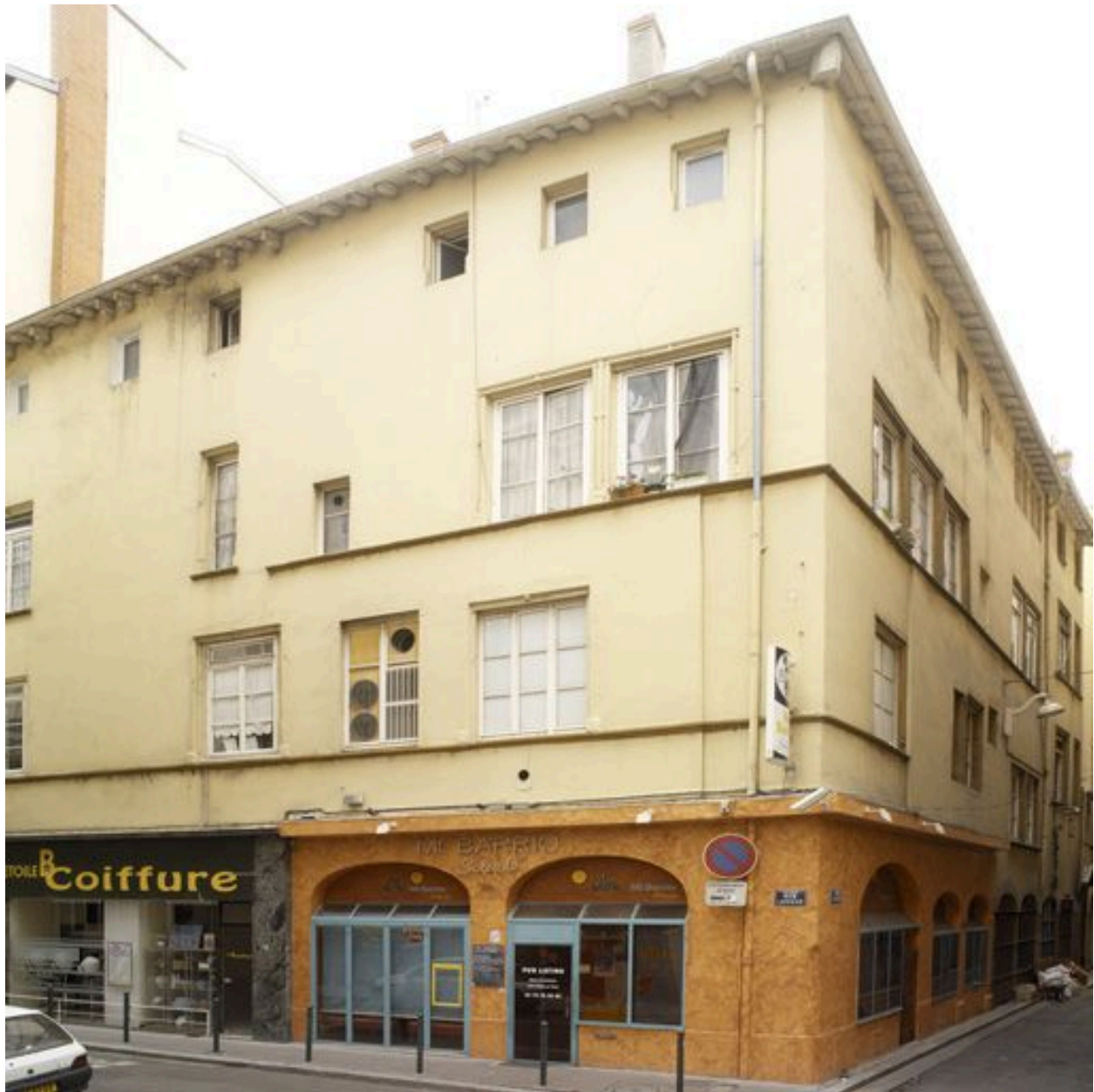
Vue générale du bâtiment 1
