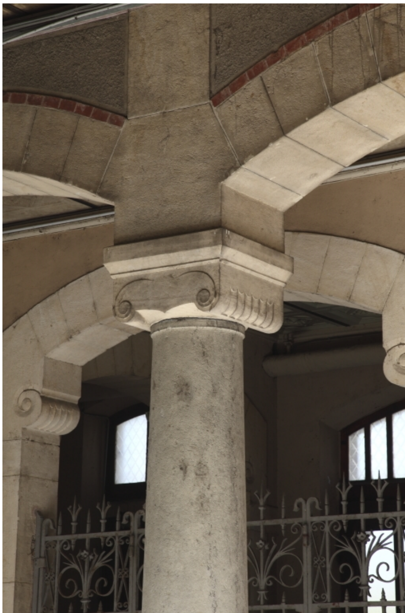
Cour H. Détail d'un chapiteau.
