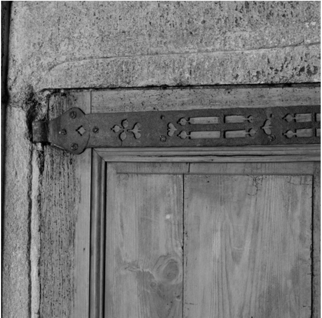
Détail des ferrures du placard de l'absidiole nord.
