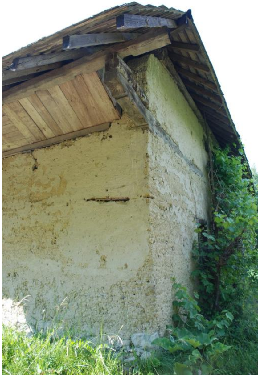
Vue de l'angle sud-est.
