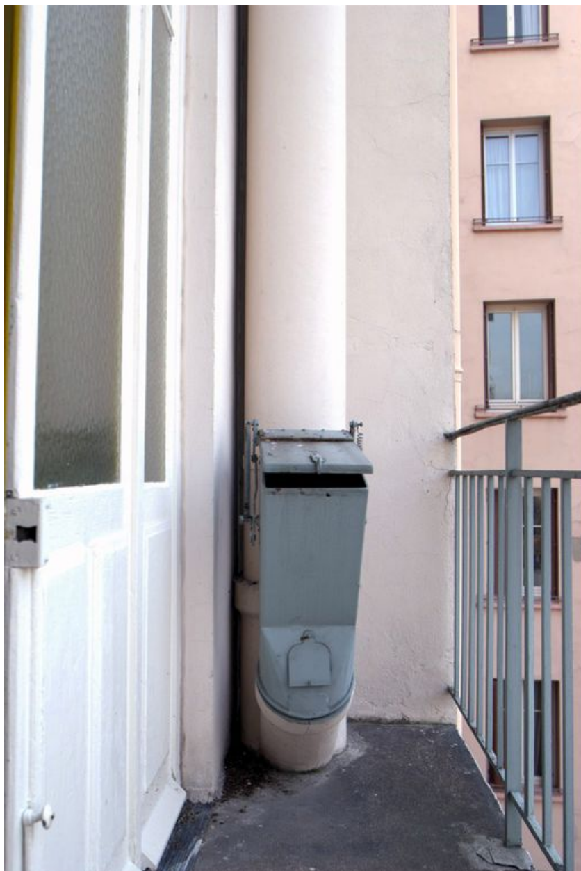
Vide-ordures, balcon du repos de l'escalier
