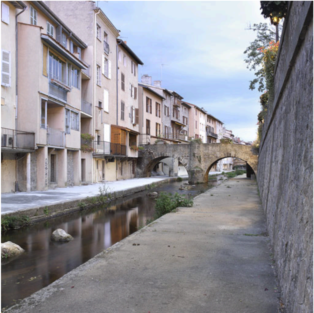
Vue du Vizézy en direction du pont d'Ecotay.
