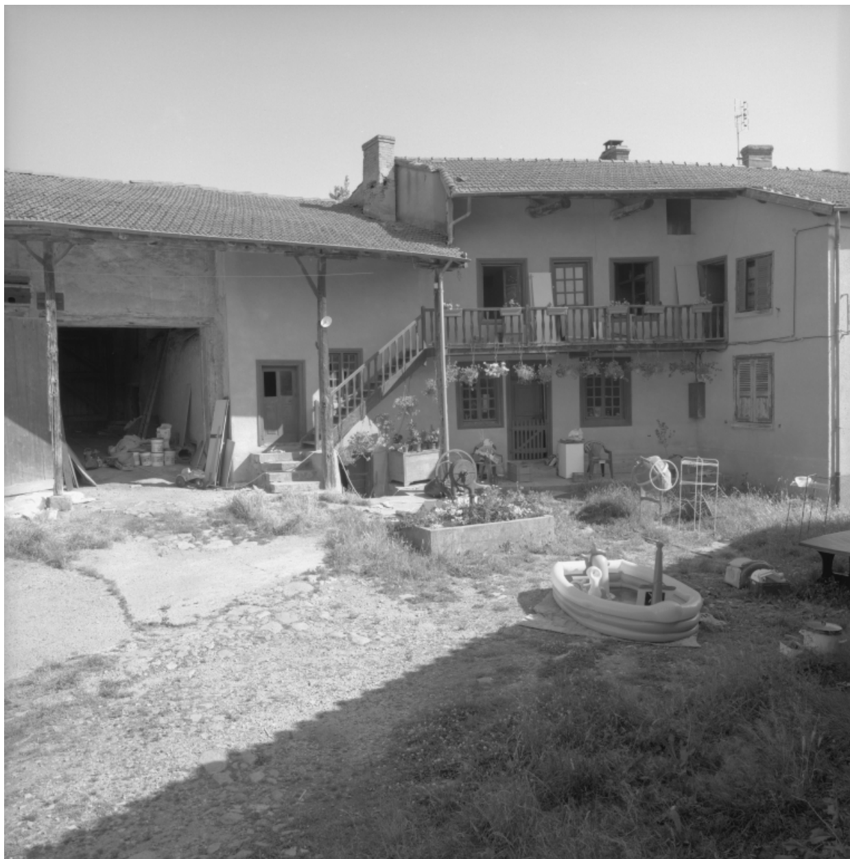
Premier ensemble. Bâtiment nord : vue d'ensemble depuis la cour.
