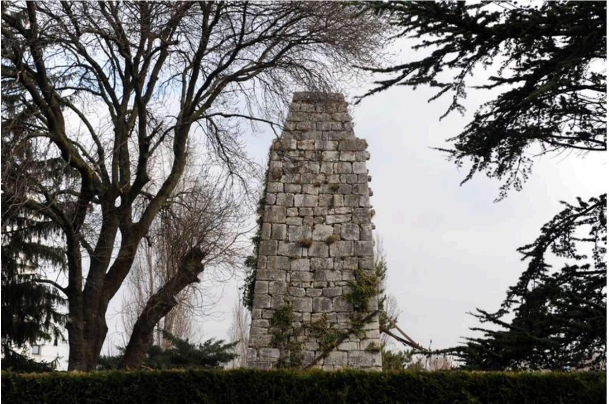
Pile subsistante en rive droite, vue générale
