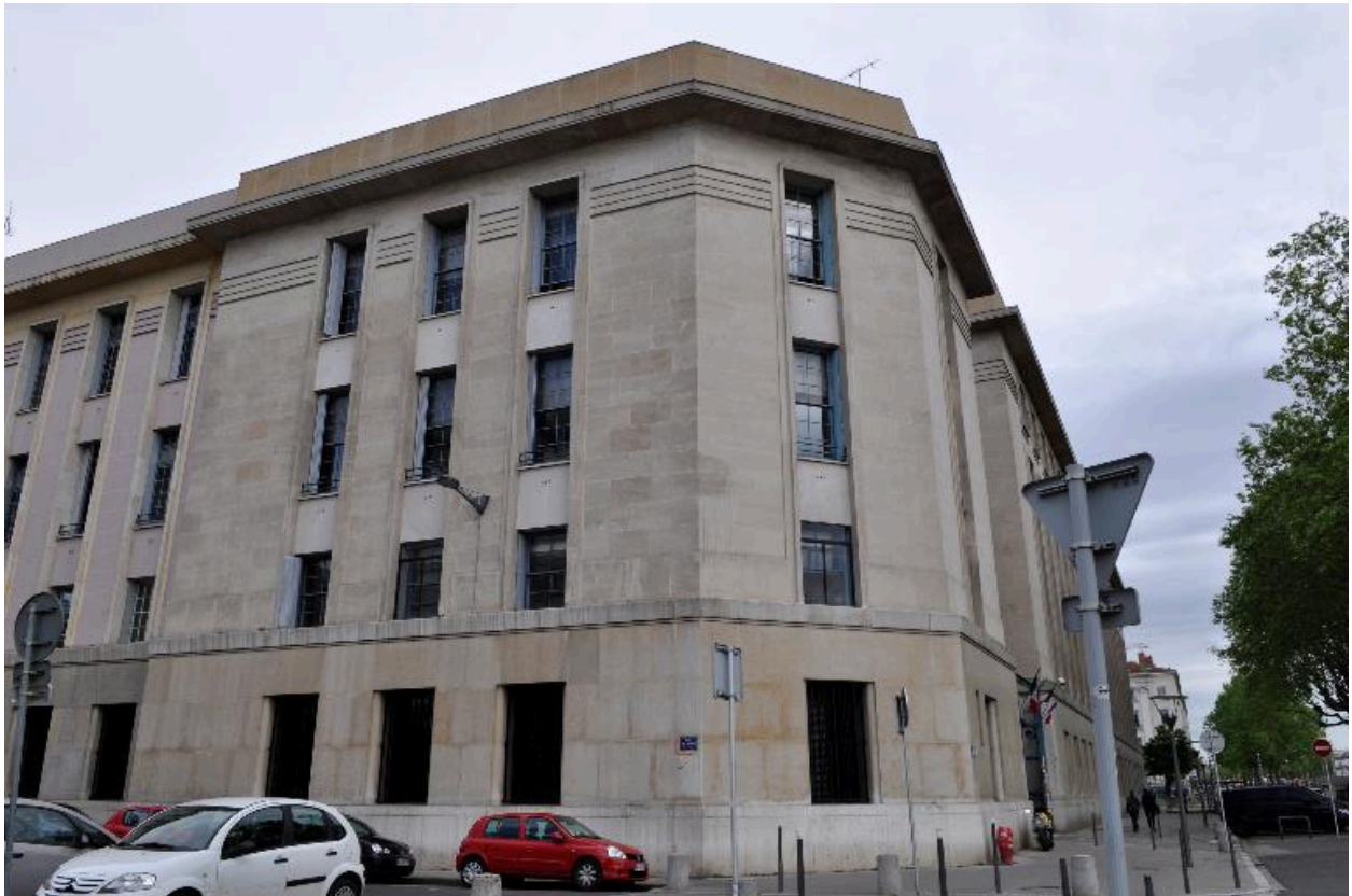
Vue du massif d'angle au sud-est, depuis le quai Gailleton
