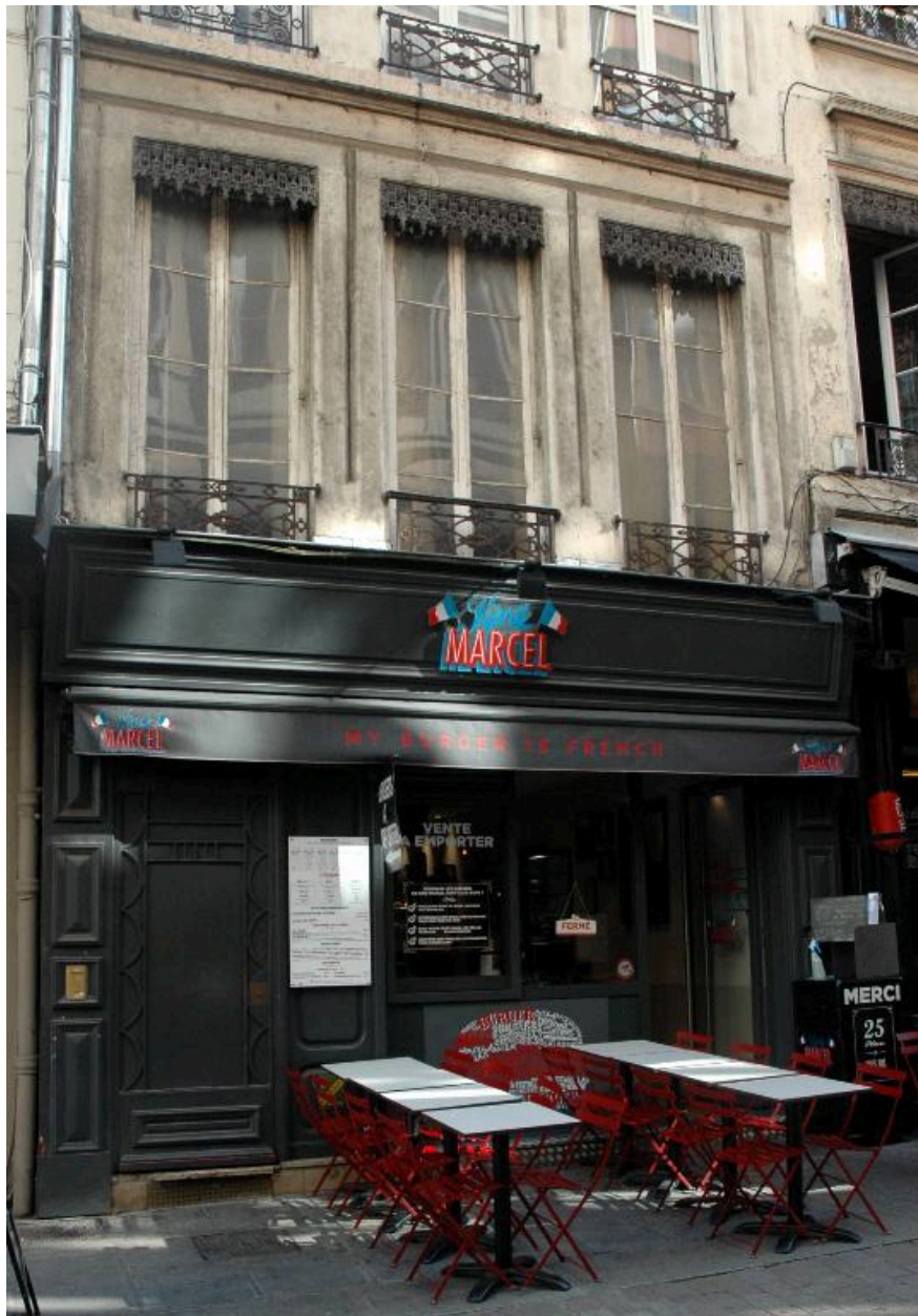
Élévation antérieure, vue du rez-de-chaussée
