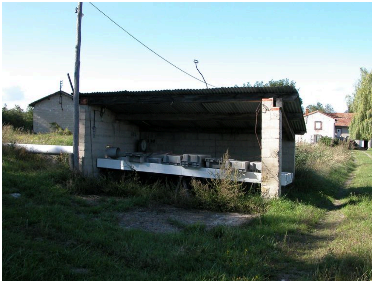
Bâtiment pour la pesée du poisson (parcelle 1986 A1 393).
