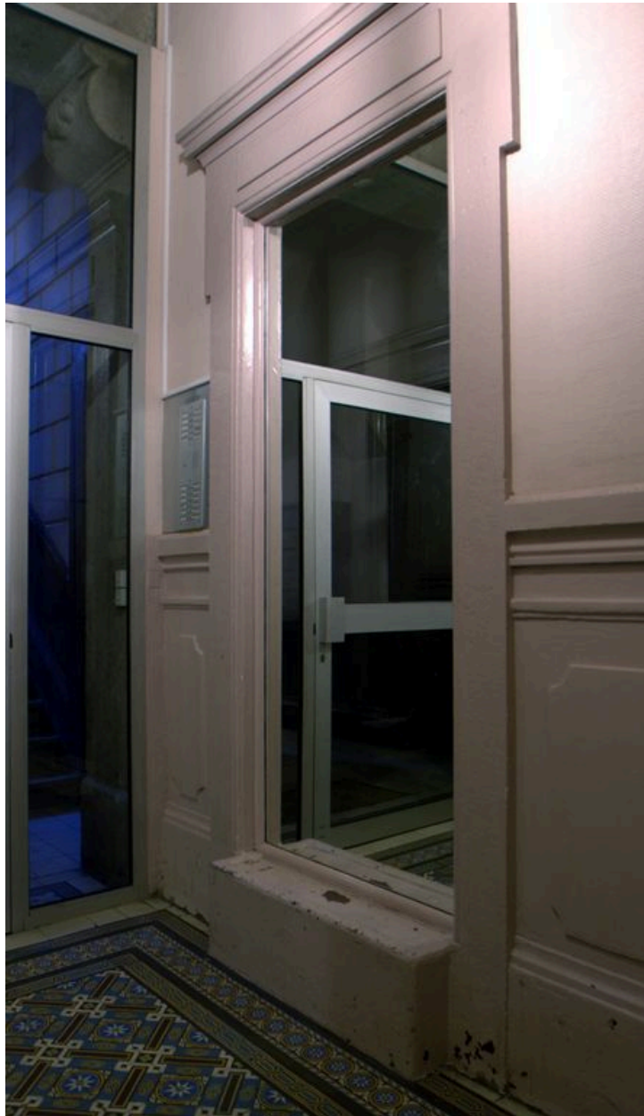
Vestibule, détail du mur ouest
