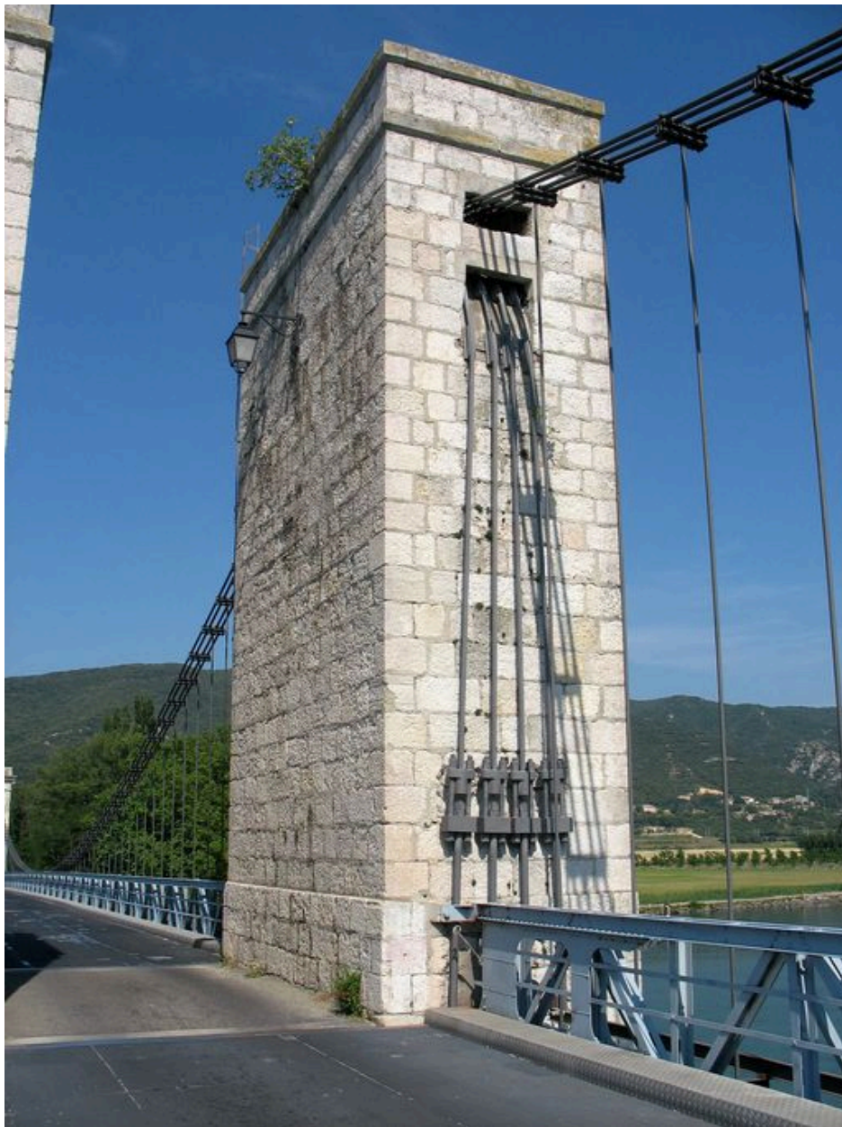
Pylône, vue partielle
