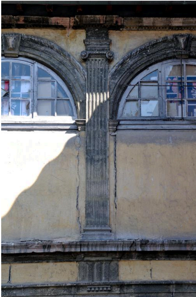
Galerie B : détail d'un pilastre
