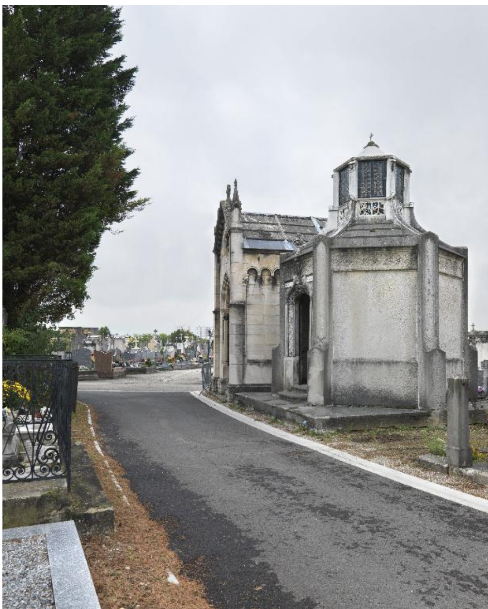
Vue de situation depuis l'allée 9, côté est
