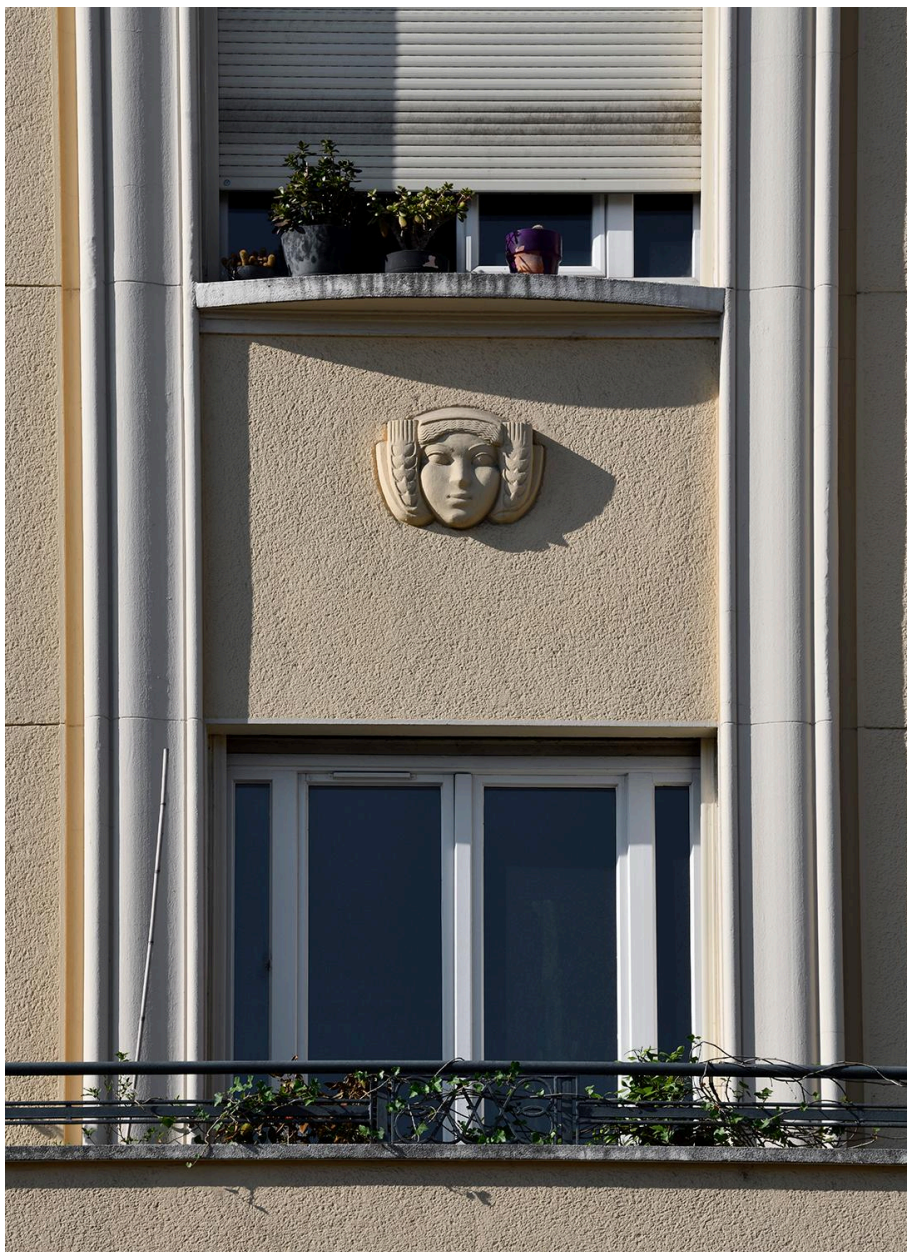
Elévation avenue des Frères-Lumière : ornementation
