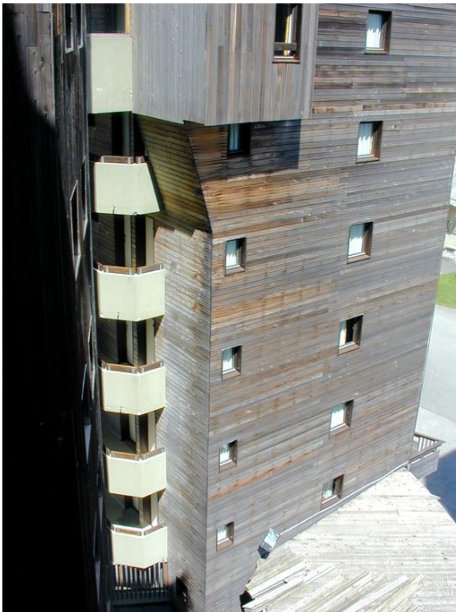
Vue sud-ouest du pignon sud, partie inférieure
