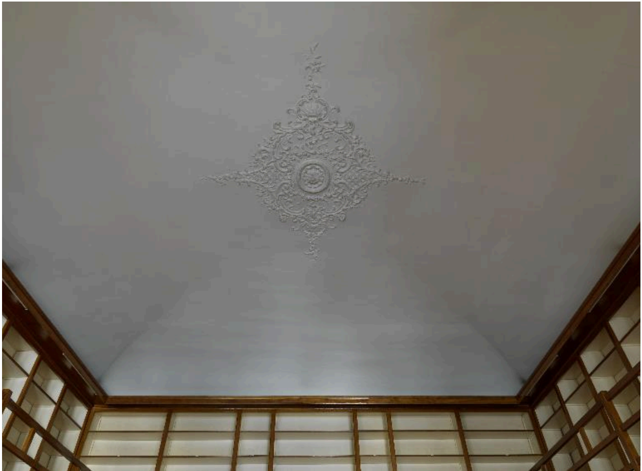
Premier étage : vue de la fausse voûte du bureau du directeur
