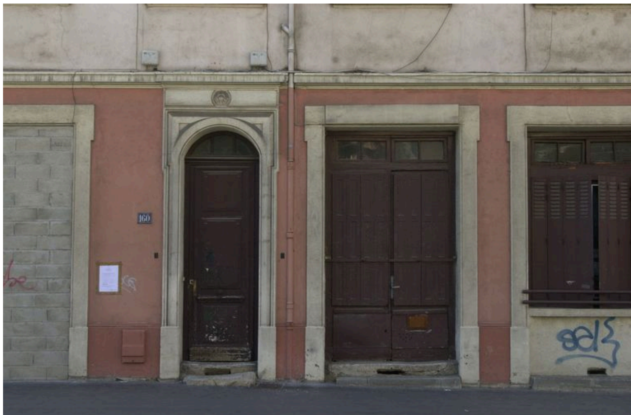
Détail du rez-de-chaussée
