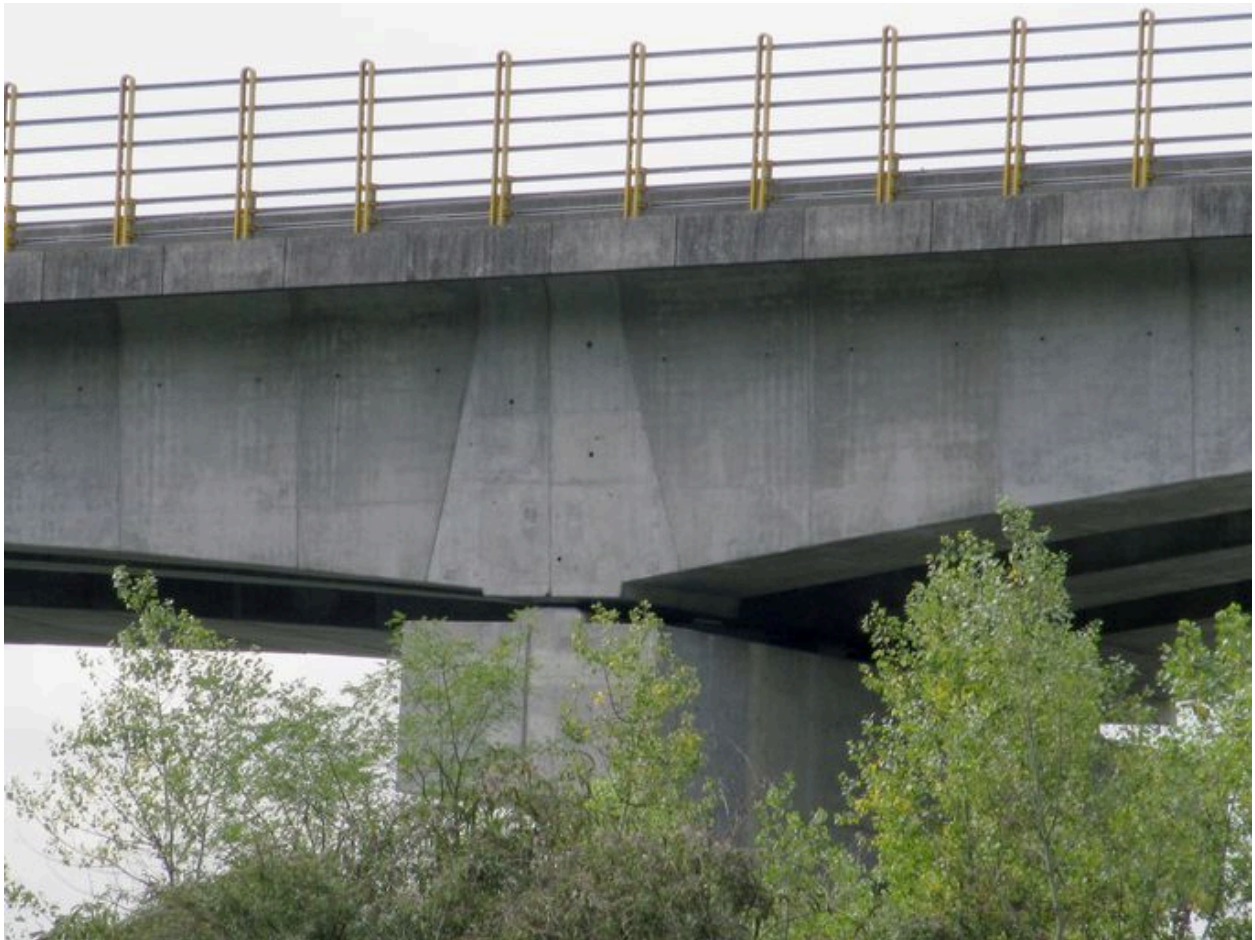
Tablier, vue partielle, face amont (depuis la rive droite)
