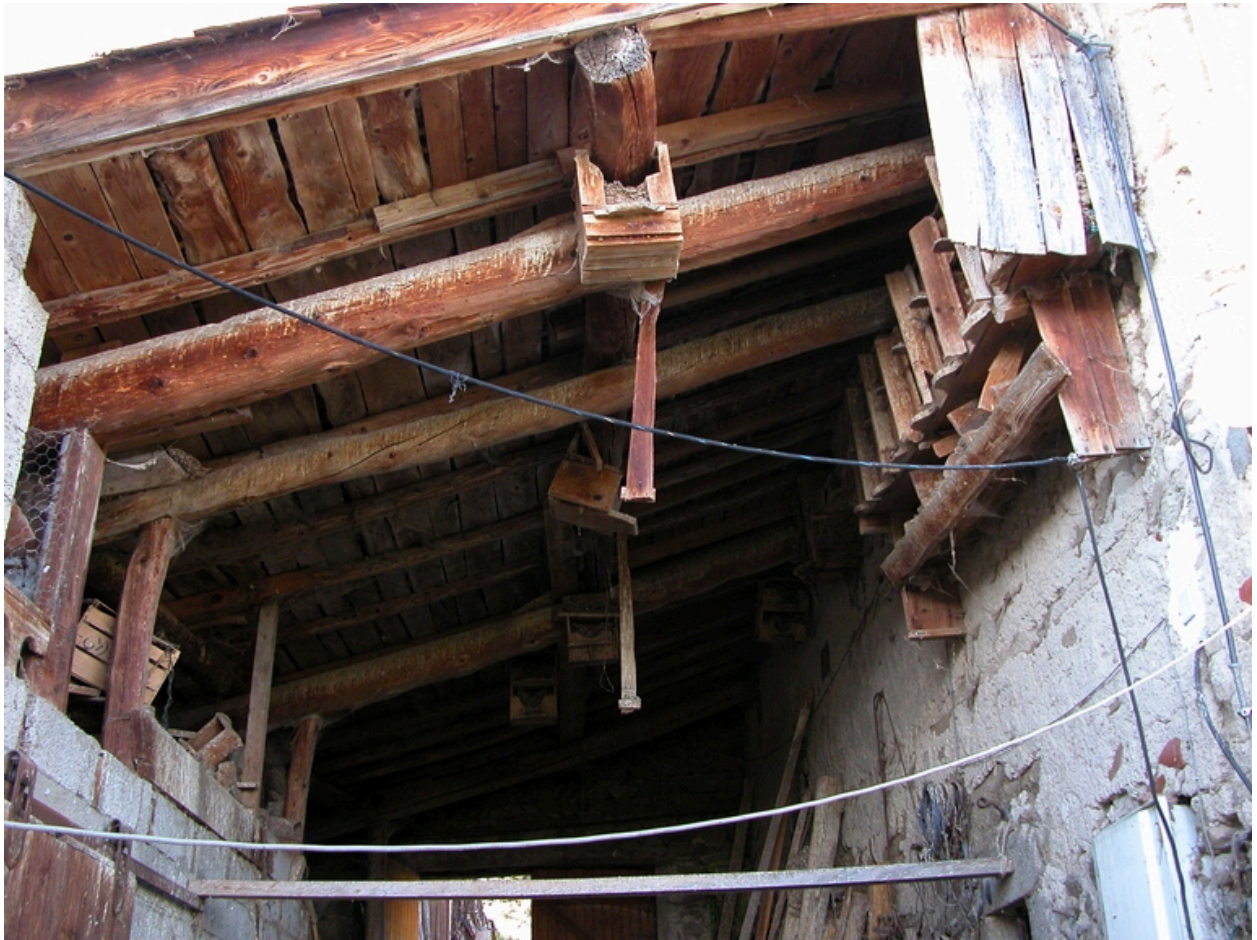
Vue intérieure du passage couvert.
