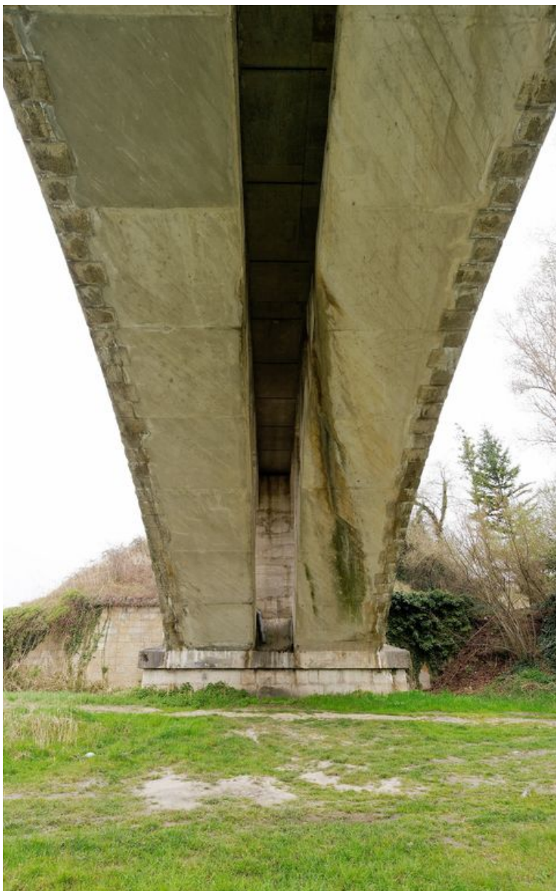
Vue partielle d'une arche (travée de rive droite) : dessous du tablier
