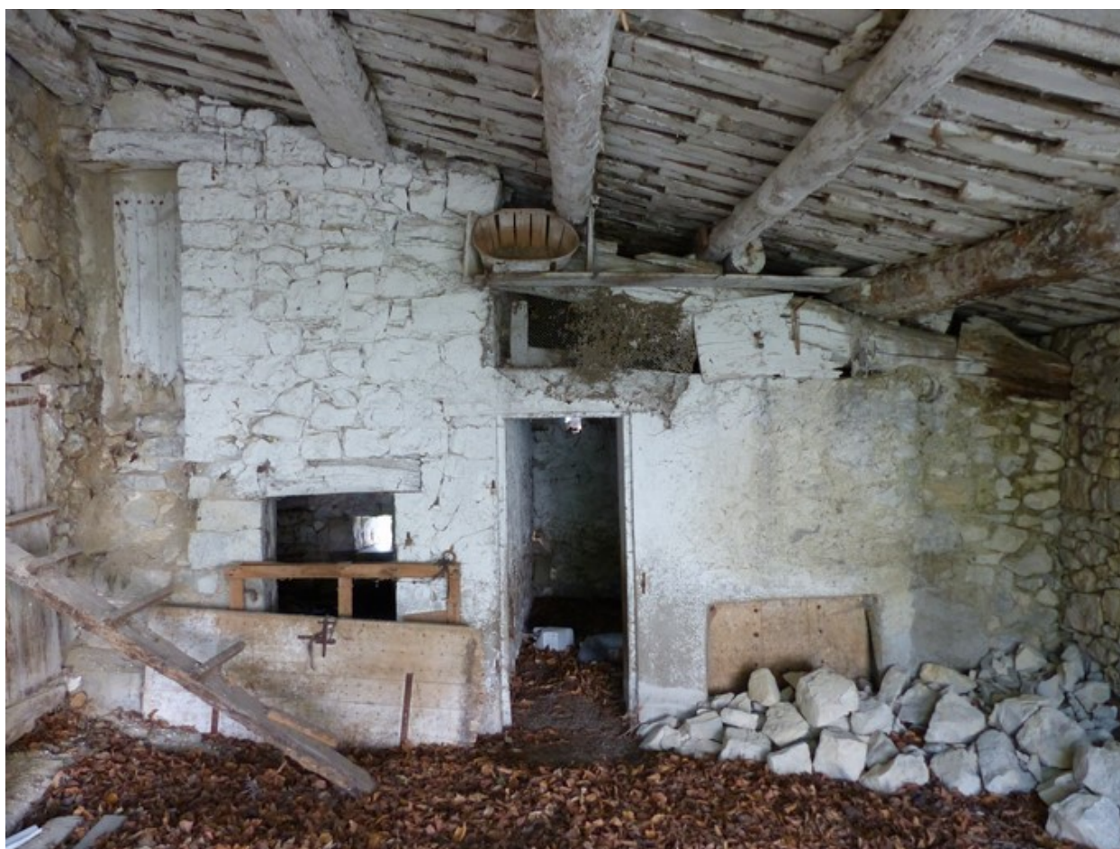
Vue de volume d'un entrepôt agricole, hameau du Moulin.
