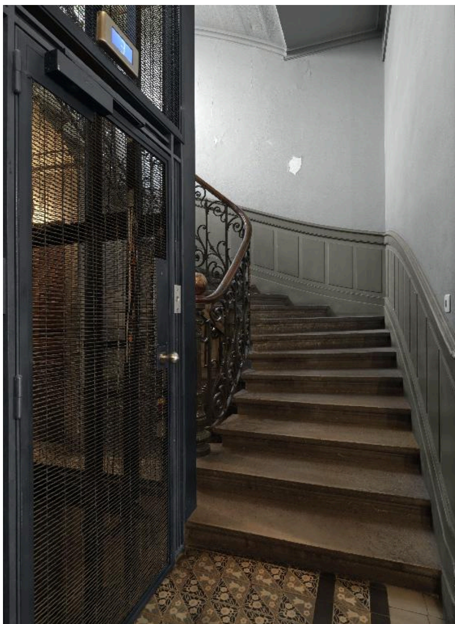
Vue intérieure : le départ de l'escalier
