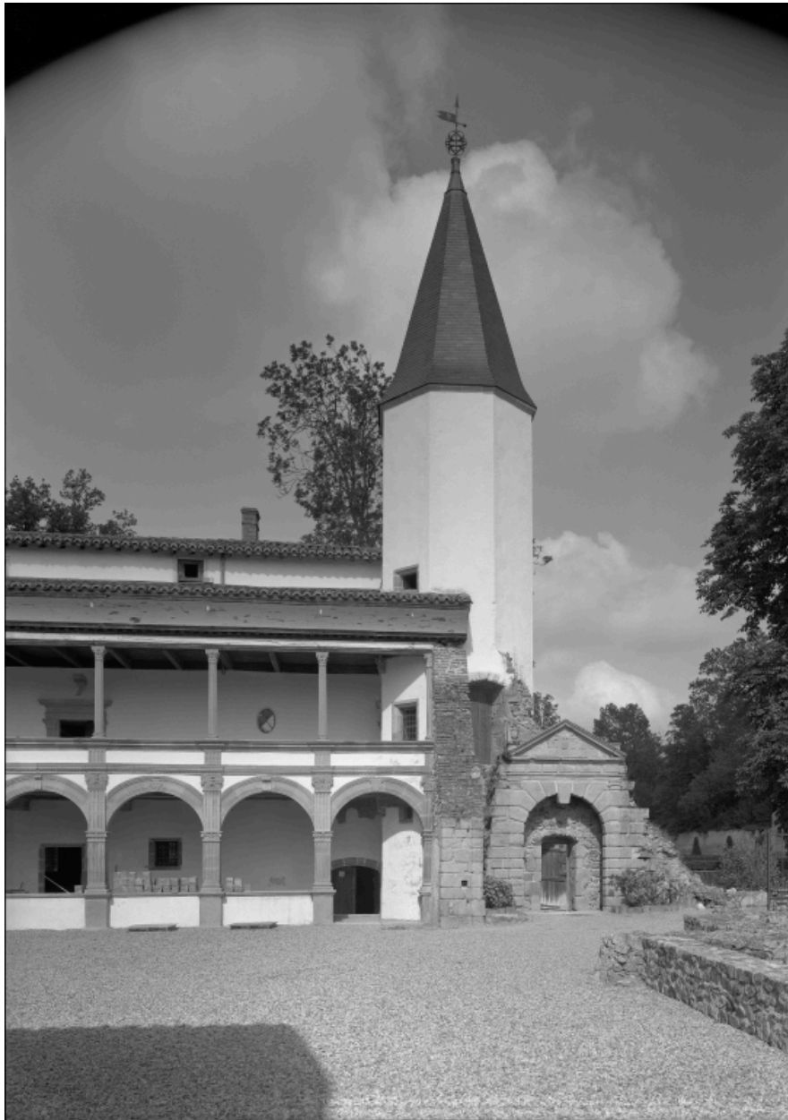
Façade sur cour du corps de galerie : détail de la partie droite de la façade avec la tour d'escalier et la porte d'accès au jardin, de l'est.
